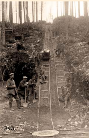
Câble transbordeur allemand du Barrenkopf.
